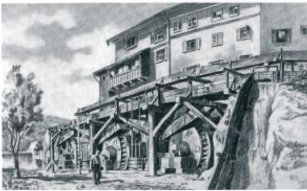
Hammerwerke Müller in Worblaufen um 1900, E. Bocchetti 1944
