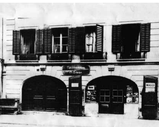
Das gleiche Haus mit einem Laden in einer Aufnahme von 1940 (Arkaden auf der rechten Seite). Foto: Bürgerarchiv Burgdorf
