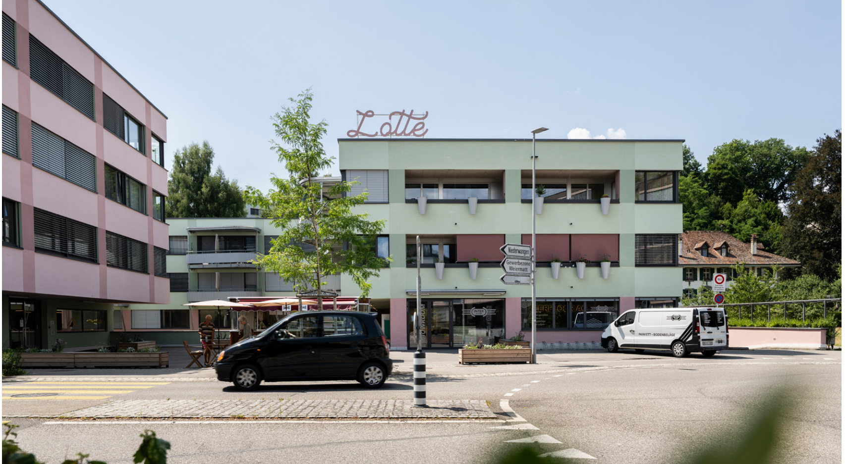
Aufwendige Verkehrs- und Siedlungsplanung: Die Entwicklung des RGSK/AP ist komplex und anspruchsvoll. Im Bild: Die Überbauung Lise & Lotte in Köniz.
