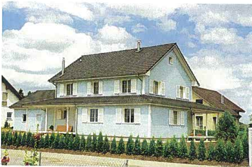
Im «blauen Haus» von Ueberstorf steht im Keller eine moderne Pelletheizung
